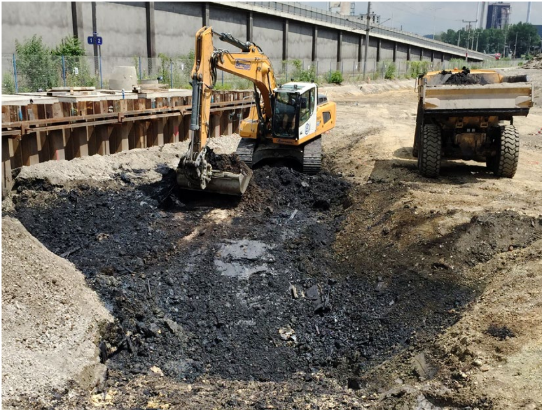
Räumung eines „Hot-Spots“ im Bereich der Filterwand
